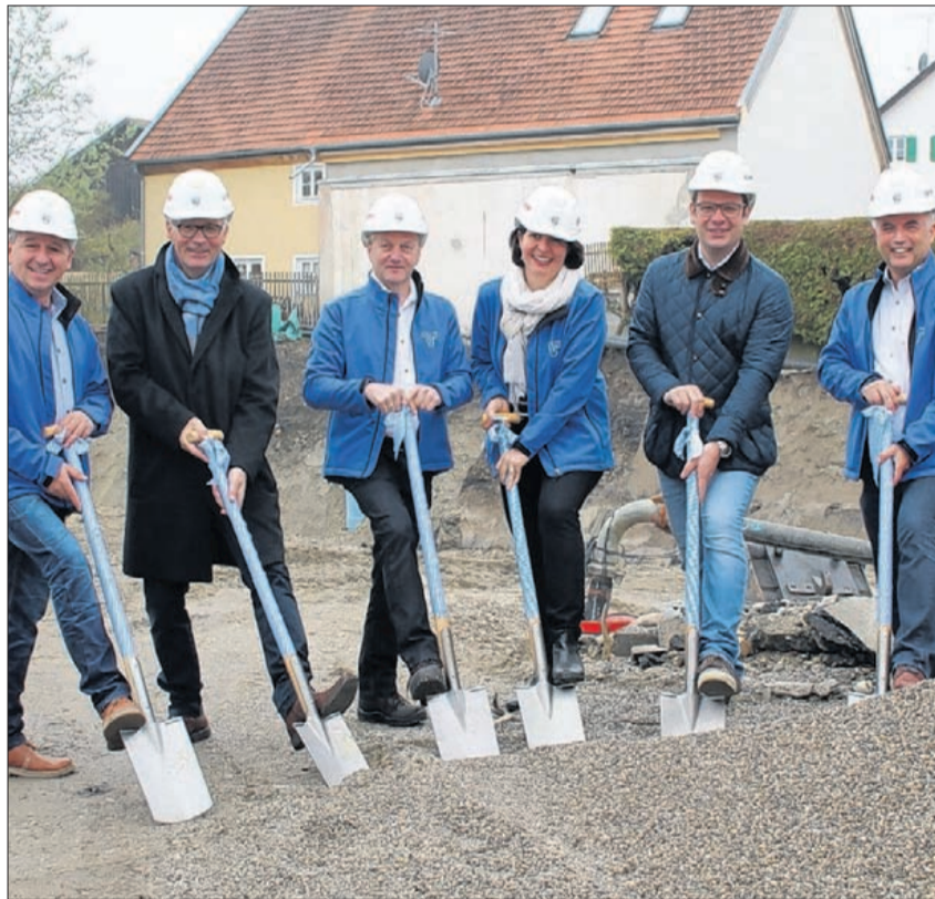
Der Anfang für das Wohn- und Geschäftshaus ist mit dem ersten Spatenstich erfolgt, v. l.: Bauleiter Erich Binder, Bürgermeister Richard Michl, Johann Forster und Martina Grunow vom Aufsichtsrat der VR-Bank Landsberg-Ammersee eG, Generalunternehmer Michael Frank und VR-Vorstandsvorsitzender Stefan Jörg. Foto: Kramer
